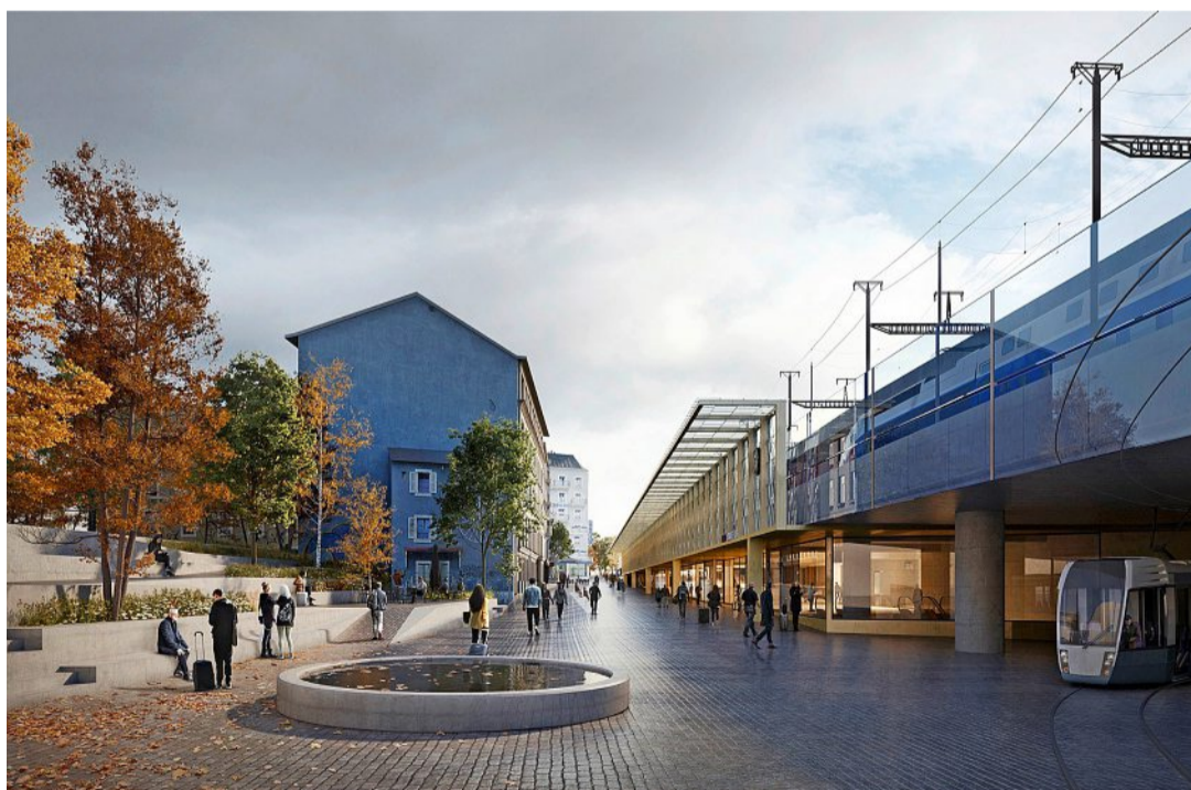
L'arrière de la gare Cornavin à l'avenir. Cet aménagement sera réalisé une fois l'extension souterraine achevée, soit vers 2030. MONNIER ARCHITECTURE DU PAYSAGE/FILIPPO BOLOGNESE IMAGES
